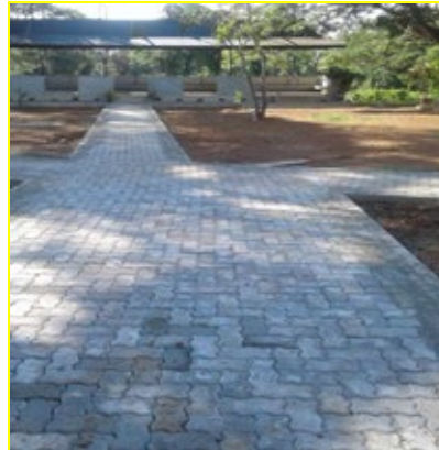
මහවේරිය විවේක කාමර අසල රථවාහන නැවතුම්පොළ සංවර්ධනය කිරීම
